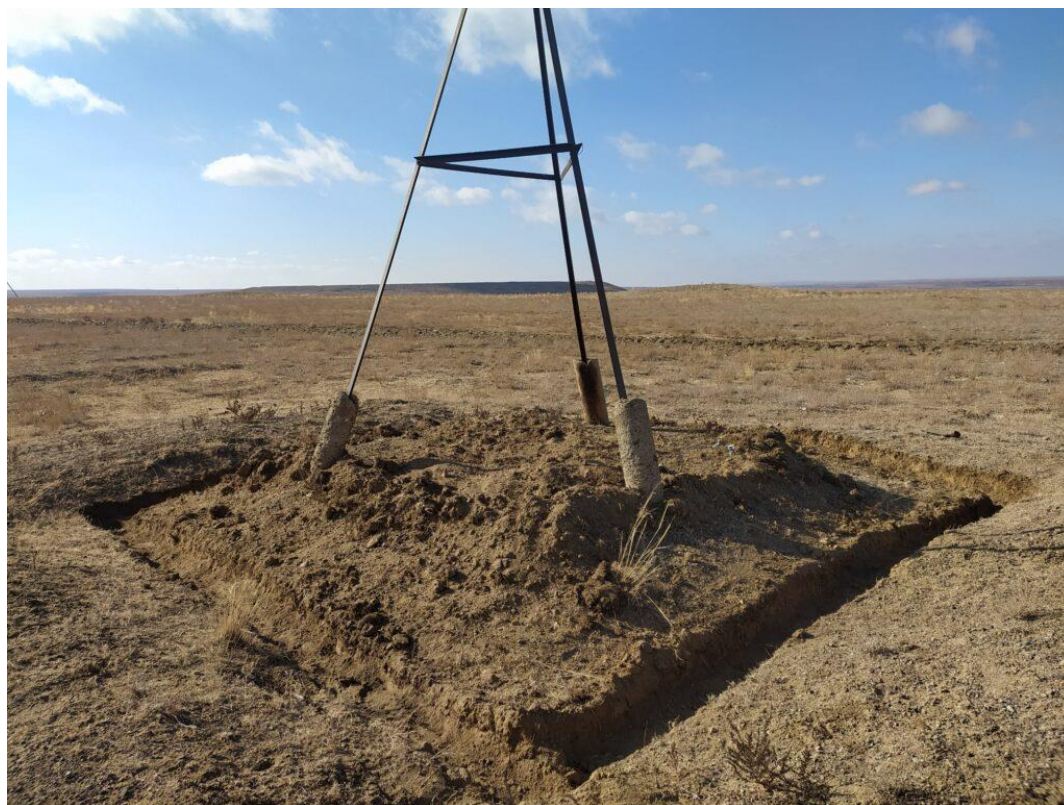
3.1-сурет-Үш қырлы пирамидалы геодезиялық пункт
